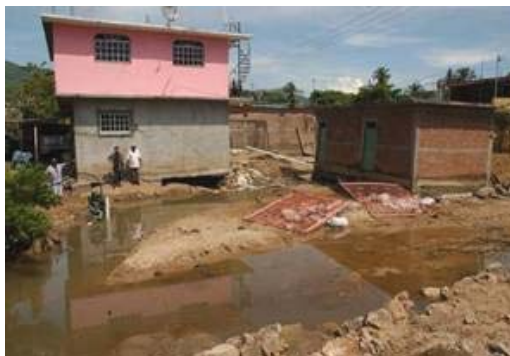
Figura 2.184 Vivienda afectada en Acapulco
