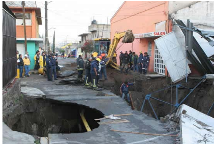
Figura 5.2 Agrietamiento en delegación Iztapalapa
