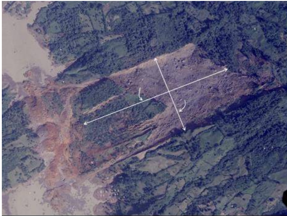
Figura 3.16 Dimensiones aproximadas del deslizamiento determinadas con equipo portátil
