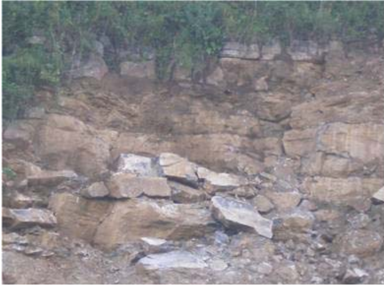
Figura 3.8 Bloques inestables en la parte alta de la escarpa de falla
