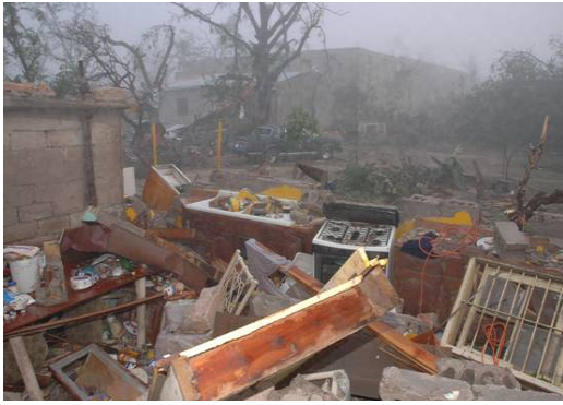
Figura 2.332 Daño total en vivienda y enseres domésticos
