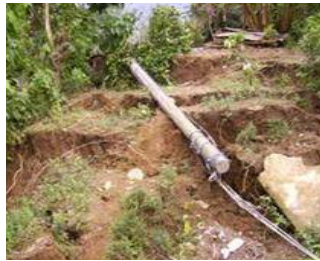
Figura 2.282 Postes dañados por deslaves o desgajamientos
