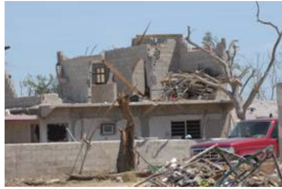
Figura 2.333 Vivienda con pérdida total a consecuencia del tornado
