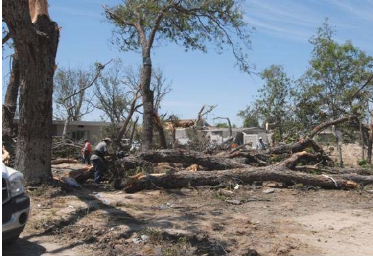
Figura 2.338 Remoción de árboles derribados por el fenómeno
