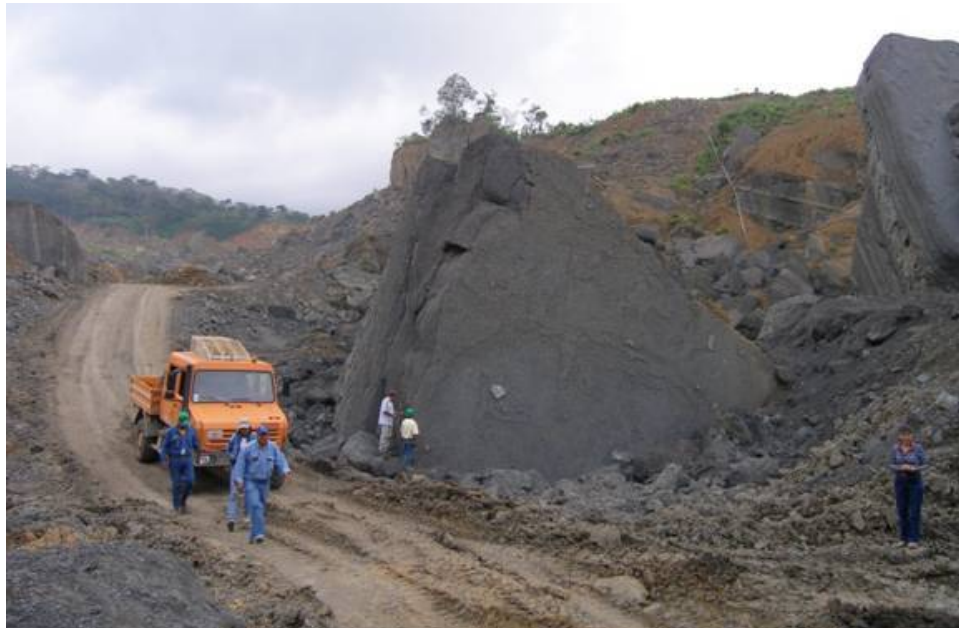
Figura 3.18 Fragmentos de roca dentro de la superficie de falla del deslizamiento: a) tomada desde el flanco izquierdo y b) tomada dentro de la superficie de falla
