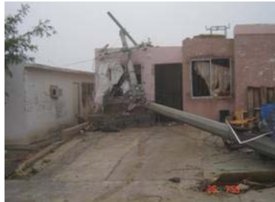
Figura 2.340 Daños en el tendido eléctrico de la colonia Villa de Fuente Figura 2.341 Daños en postes y tendido eléctrico
