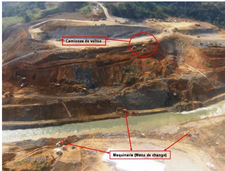
Figura 2.286 Dimensiones del canal de Juan de Grijalva, apenas se puede observar la maquinaria que se utilizó en los trabajos de construcción
