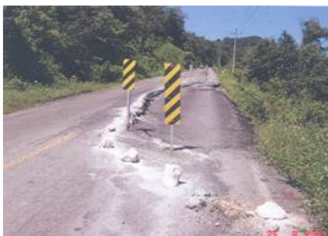
Figura 2.169 Asentamientos e inestabilidad de taludes ocasionados por el impacto del ciclón tropical Dean en la infraestructura carretera
