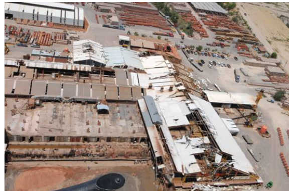
Figura 2.342 Vista aérea de daños en fábrica de laminados de barro del municipio de Piedras Negras
