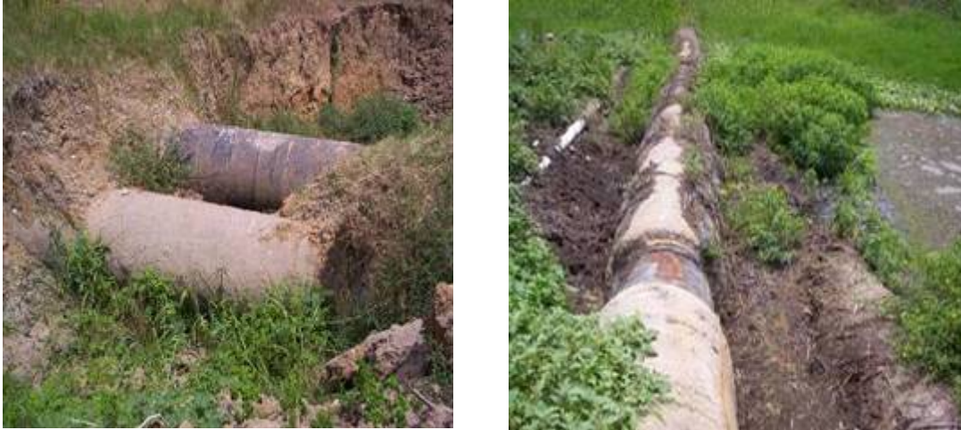
Figura 2.250 Presencia de líneas de PEMEX en el sistema de drenes Bermúdez-Lomitas
