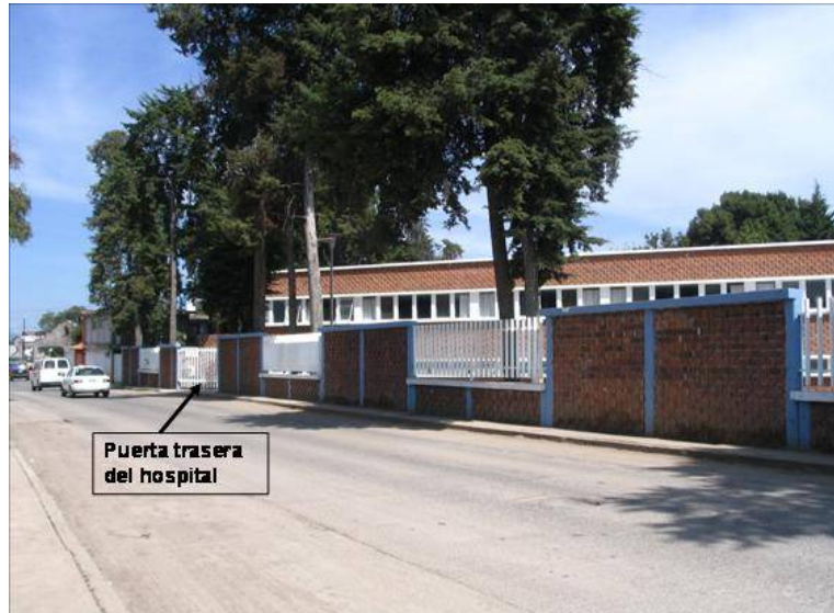
Figura 2.162 Vista del Hospital Tulancingo y del Río Chico de Tulancingo
