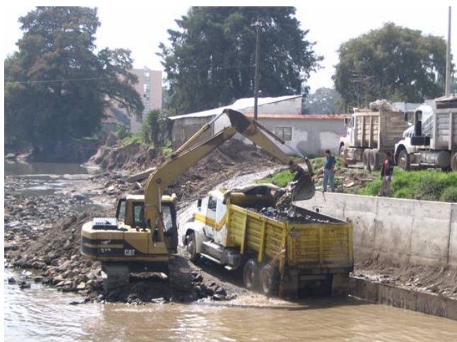
Figura 2.168 Acciones de desazolve sobre el cauce del Río San Lorenzo
