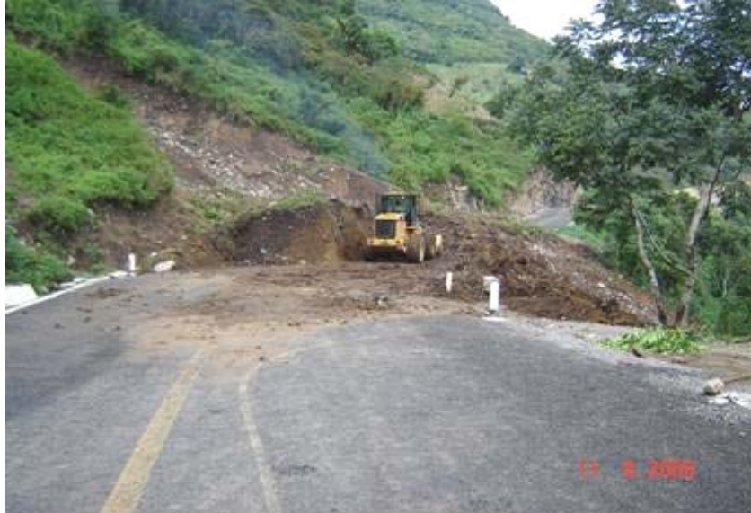
Figura 2.143 Remoción de material térreo y reparación de caminos
