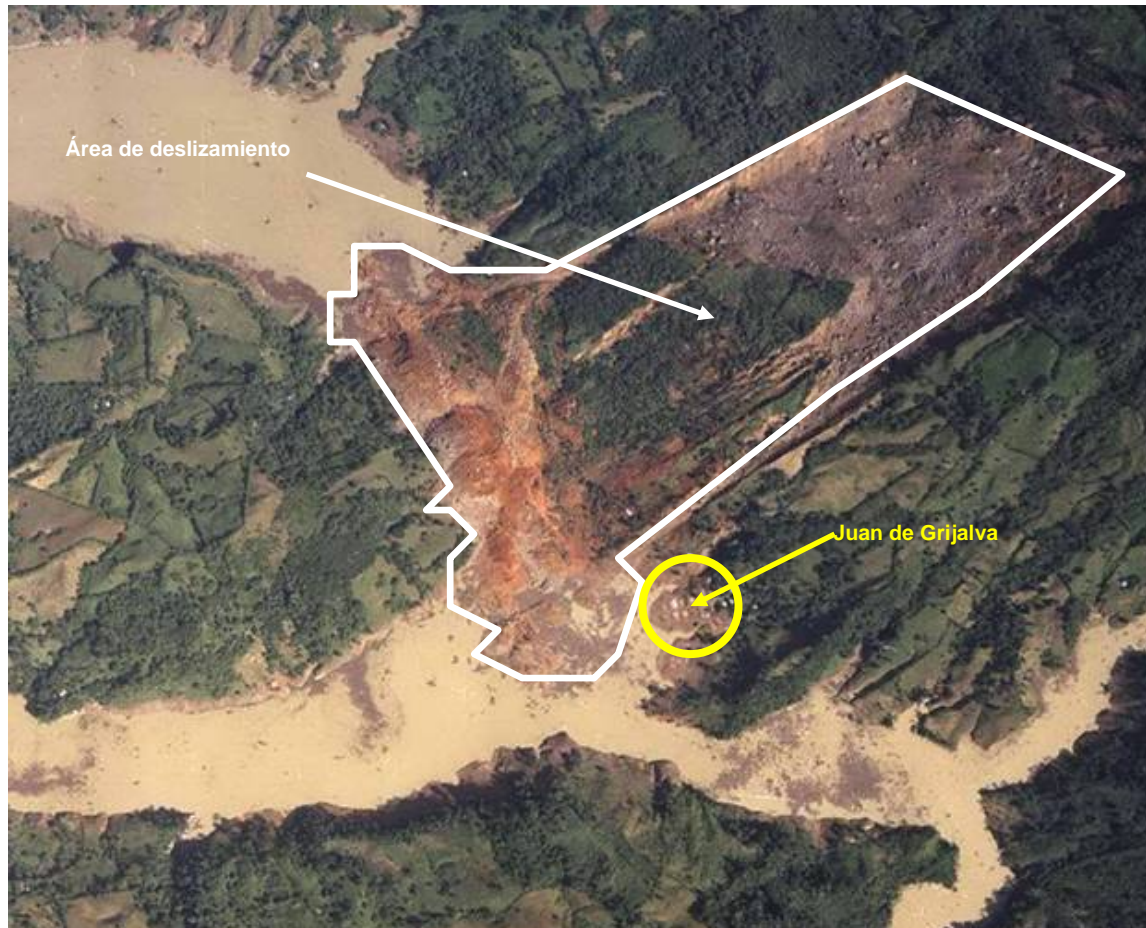
Figura 2.284 Imagen aérea del taponamiento del río Grijalva a consecuencia del deslizamiento ocurrido el 4 de noviembre a la altura de la localidad de Juan de Grijalva
