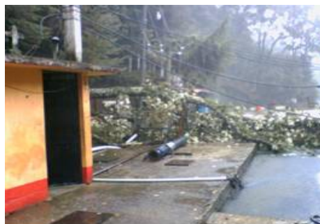
Figura 2.140 Caída de árboles en infraestructura hidráulica en el municipio de Teziutlán
