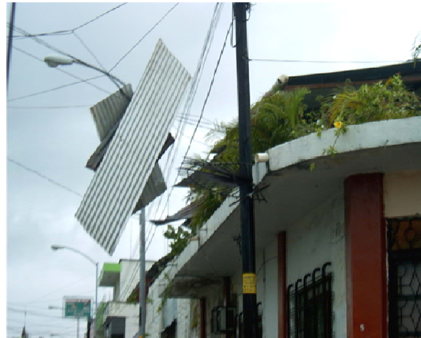
Figura 2.35 Desprendimiento de techos de lámina en los municipios de Suchiate y Tapachula a causa de Bárbara
