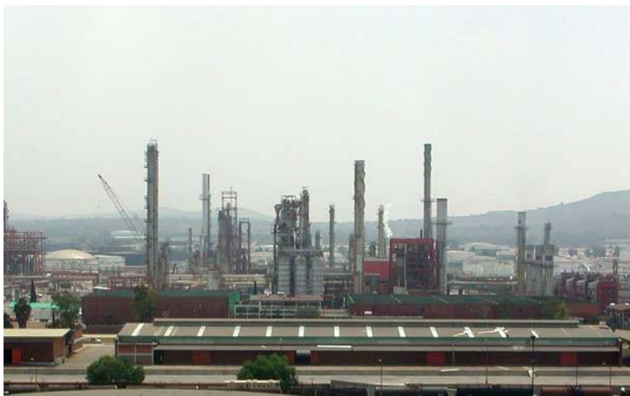
Figura 2.117 Complejo petroquímico El Escolín
