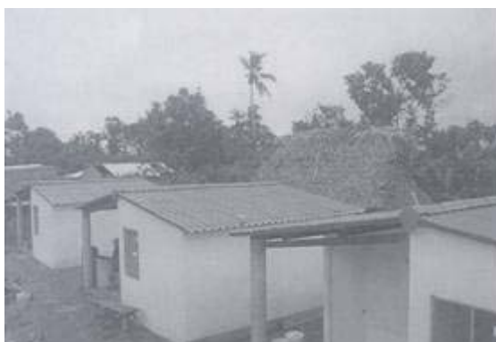
Figura 2.111 Viviendas construidas mediante el programa de autoconstrucción supervisada
