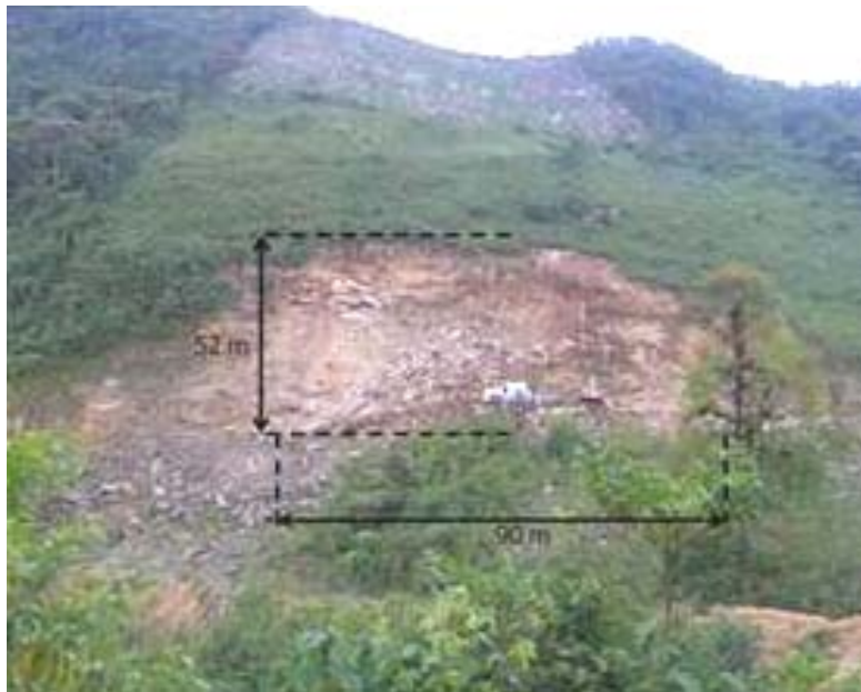
Figura 3.3 Dimensiones aproximadas del área deslizada
