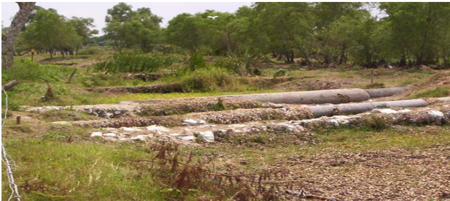
Figura 2.208 Ductos de PEMEX que al cruzar corrientes de agua retienen basura, hierbas y vegetación
