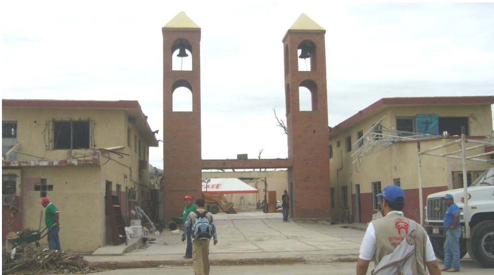
Figura 2.315 Daños a iglesia de Villa de Fuente
