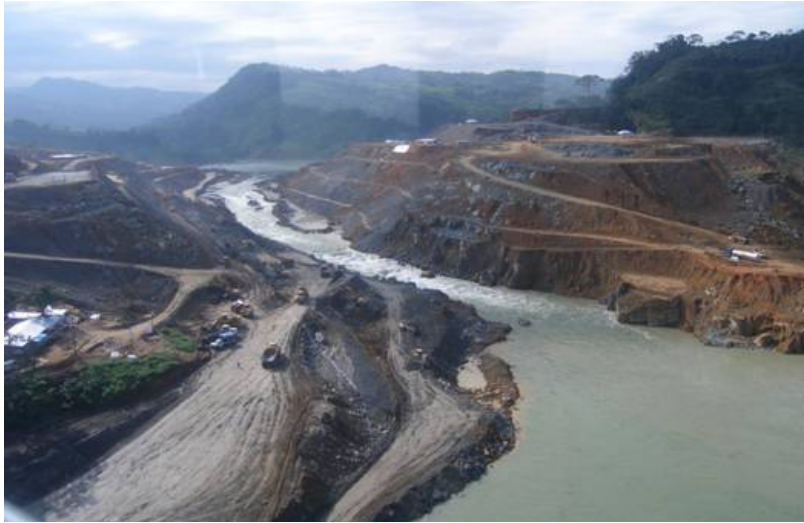
Figura 3.22 Vista del canal excavado en la segunda etapa, febrero 12, 2008
