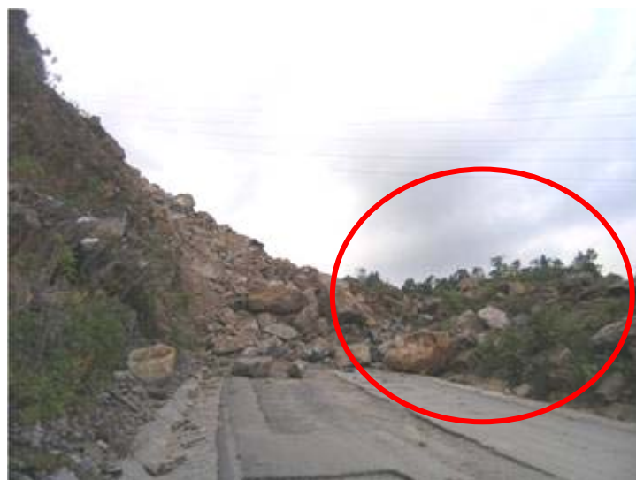
Figura 3.7 Fragmentos de roca depositados al costado de la carretera y que contuvieron el deslizamiento
