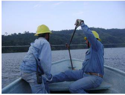
Figura 2.280 Retiro de conductores energizados
