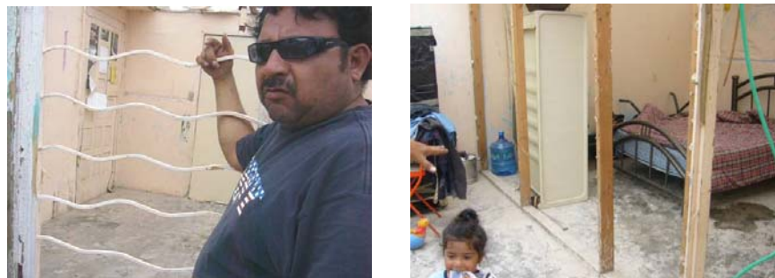
Figura 2.319 Persona que narró que se produjo succión dentro de su casa una vez que se desprendió el techo, y que tuvo que proteger a sus hijos pequeños, sujetándose de los muebles
