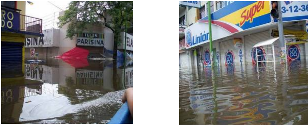
Figura 2.242 Daños en comercios en Villahermosa a causa de las inundaciones
