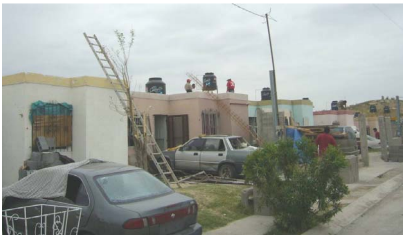
Figura 2.313 Los tinacos fueron desplazados de sus lugares, por lo que se tuvieron que instalar nuevos
