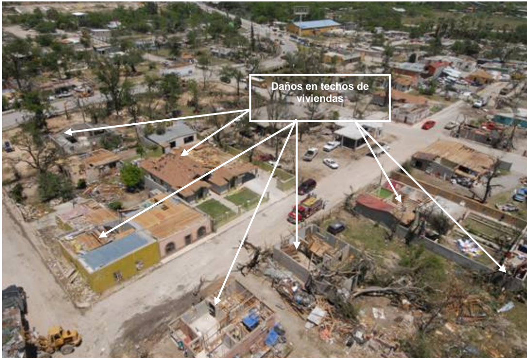
Figura 2.32 Daños en los techos de viviendas afectadas en la colonia Villa de Fuente del municipio de Piedras Negras
