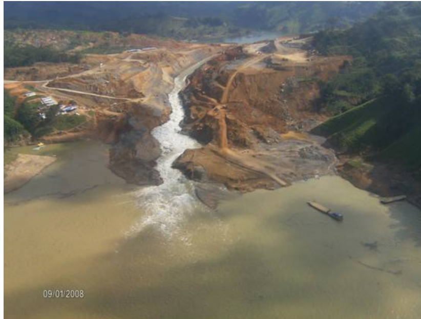
Figura 2.285 Funcionamiento del canal en su primera etapa
