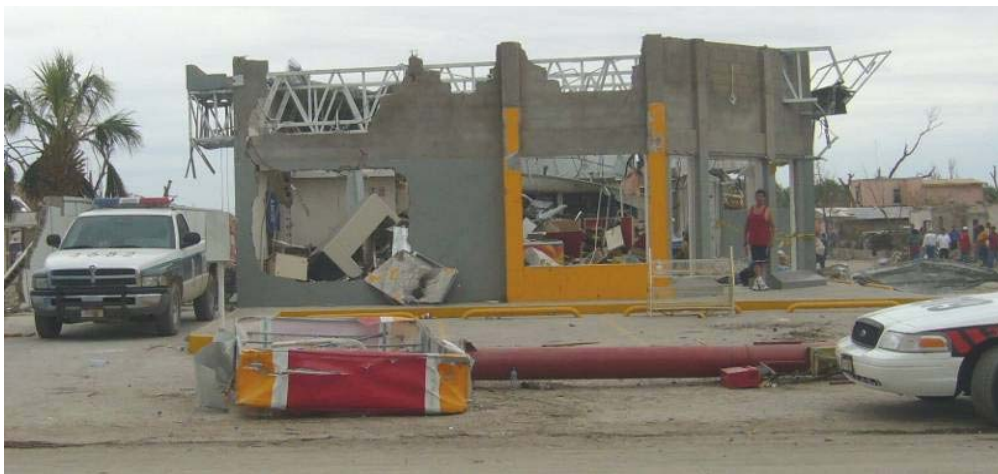
Figura 2.316 Daños a tienda "Oxxo". Nótese el poste metálico con el anuncio publicitario derribado
