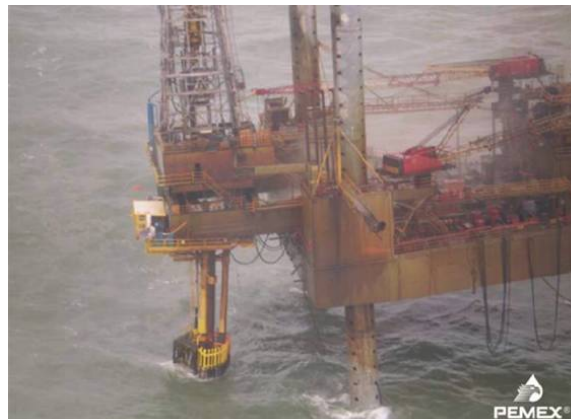
Figura 2.298 Plataforma Usumacinta recargada en la plataforma Kab-101
