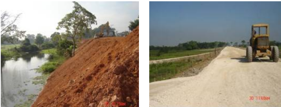
Figura 2.251 Reparación del bordo Gaviotas
