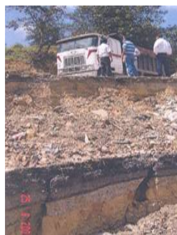
Figura 2.169 Asentamientos e inestabilidad de taludes ocasionados por el impacto del ciclón tropical Dean en la infraestructura carretera
