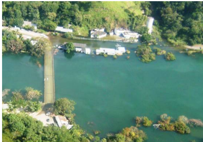
Figura 2.279 Camino y puente inundado a consecuencia del aumento en los niveles del Río Grijalva
