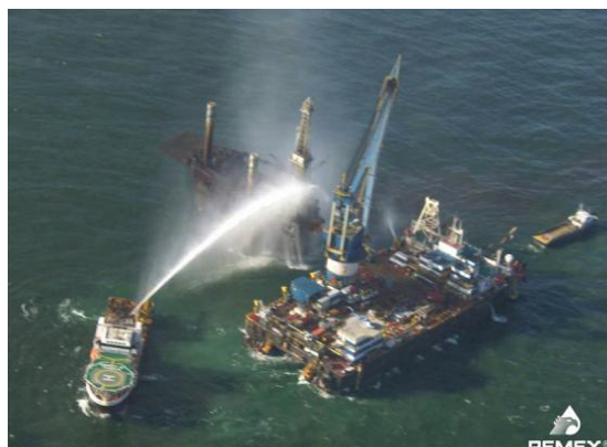
Figura 2.300 Trabajos de dispersión de gas a través de cortinas de agua
